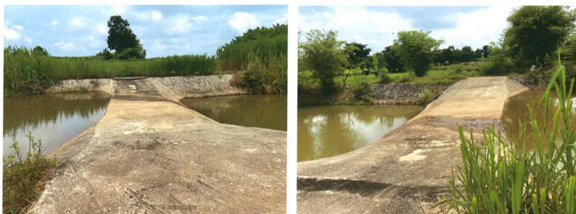
(๖) ก่อสร้างฝายชะลอน้ำคอนกรีตเสริมเหล็ก ๑ จุด หมู่ที่ ๗ ตำบลบึงปรือ อำเภอเทพารักษ์ จังหวัดนครราชสีมา
