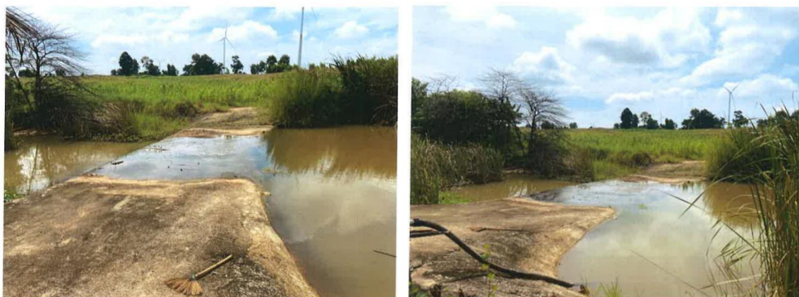
(๕) ก่อสร้างฝายชะลอน้ำคอนกรีตเสริมเหล็ก ๑ จุด หมู่ที่ ๖ ตำบลบึงปรือ อำเภอเทพารักษ์ จังหวัดนครราชสีมา
