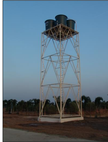
ก่อสร้างหอเก็บน้ำ ๑ หลัง
