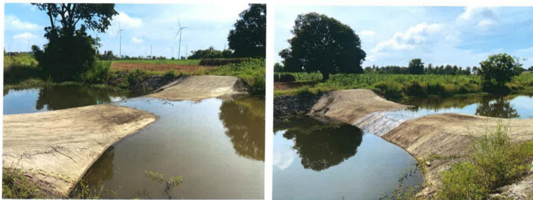
(๔) ก่อสร้างฝายชะลอน้ำคอนกรีตเสริมเหล็ก ๑ จุด หมู่ที่ ๕ ตำบลบึงปรือ อำเภอเทพารักษ์ จังหวัดนครราชสีมา
