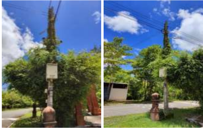
จุดที่ ๓ ลานจอดรถ พิกัด ๑๔.๗๖๒๑๘๑๗, ๑๐๓.๓๖๙๐๑๙๘ ประกอบด้วย
