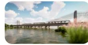
สะพานรถไฟคอนกรีตเชิงแฉ่งแรก และแห่งเดียวในประเทศไทย (ช่วงนครปฐม-หนองปลาไหล)
