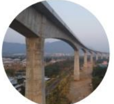
ทางรถไฟยกระดับสูงที่สุดในประเทศไทย (ช่วงมวกะเหมา-คลองขนานจิตร) จุดสูงสุด 48-50 ม.
